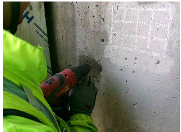
탄산화깊이 측정 현황
