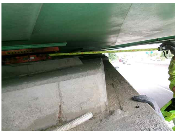
받침장치 연단거리 측정
