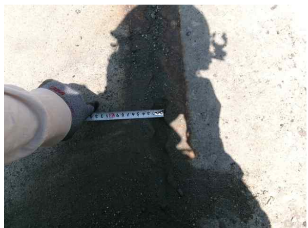
신축이음 이동량 측정
