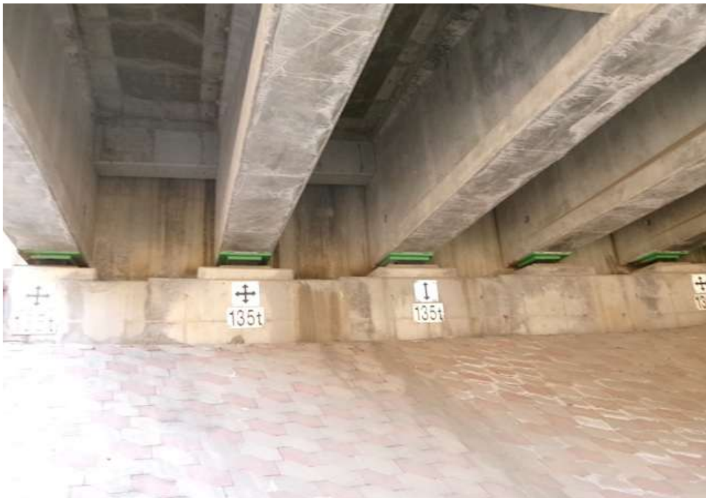
사능1교(상) 교대 전경
