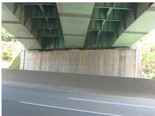
교대 A1 전경
